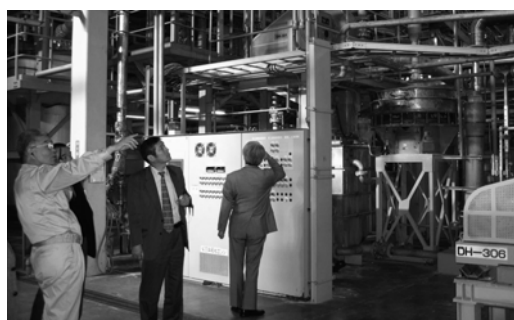
Fig. 8 新規洗浄設備
